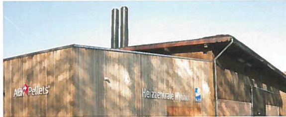
Die Heizzentrale Wylihof in Luterbach verwendet AEK-Pellets.
