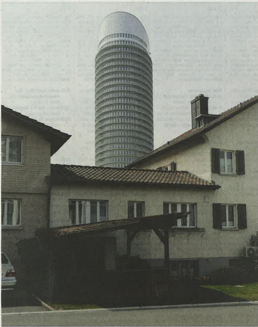
Der Jabe-Tower überragt den dörflichen Teil Dübendorfs.
